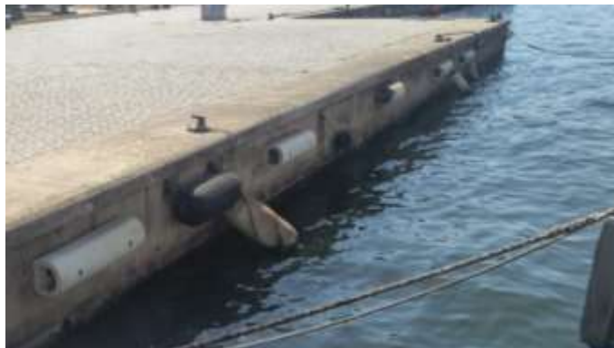
Figura 12. Equipamiento náutico existente en buen estado en la zona de concesión
