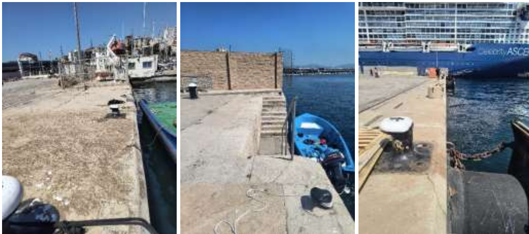
Figura 1. Fotografías tomadas durante la inspección visual realizada
