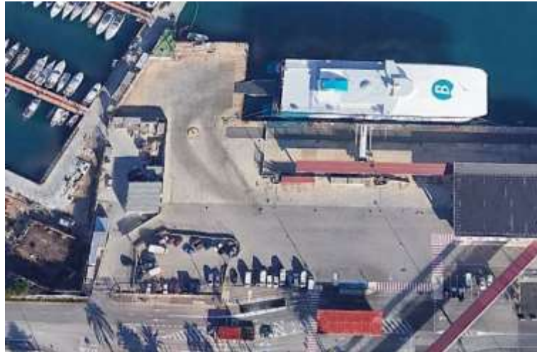
Figura 2. Operativa actual del Muelle de Poniente
