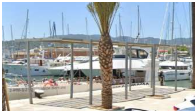
Figura 15. Elementos existentes que deben desmontarse en la zona de concesión
